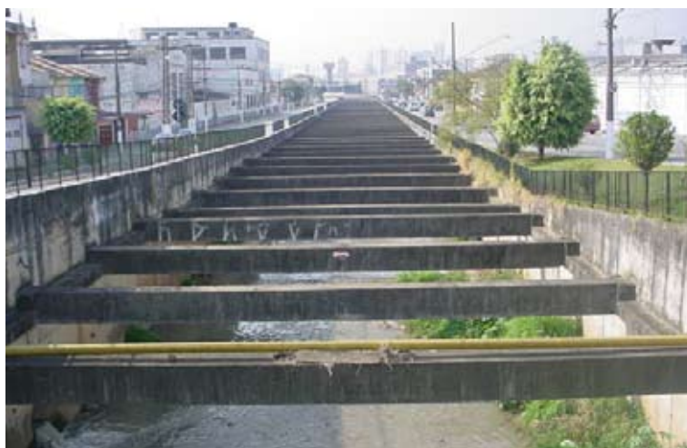
Figura 1.2.3.d – Foto de rio canalizado. Fonte: Secretaria de Obras e Serviços Públicos de Guarulhos.
