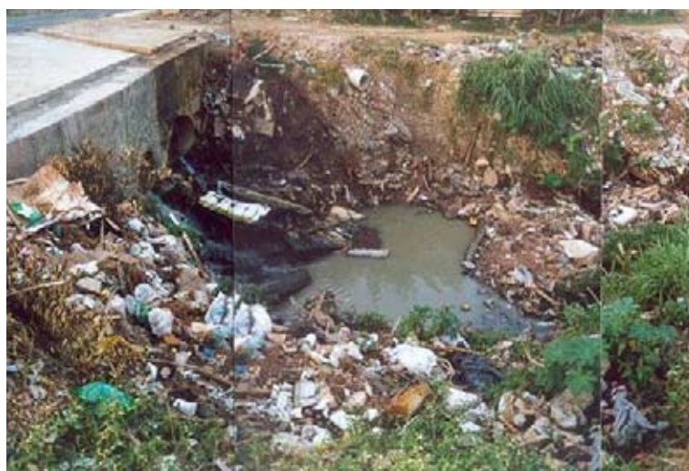
Figura 1.2.4 – Córrego com despejo de lixo. Fonte: Secretaria de Obras e Serviços Públicos de Guarulhos
