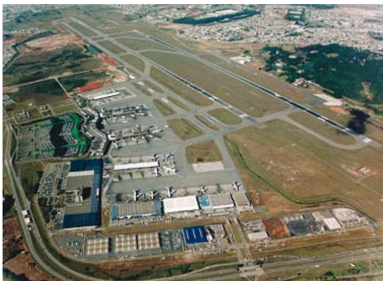
Figura 2.5.3.b – Foto panorâmica da planície aluvial do Rio Baquirivu Guaçu, depois da implantação do aeroporto. Fonte: INFRAERO
