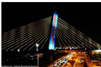
Viaduto da Cidade de Guarulhos
