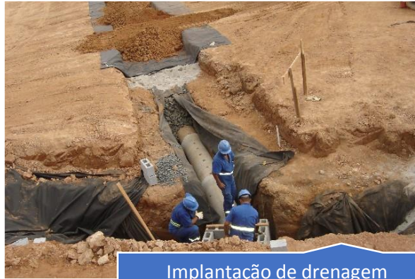
Implantação de drenagem subterrânea (Fonte: Cepollina, 2017)
