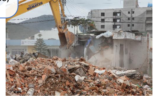
Entulhos de demolição – Classe IIB
