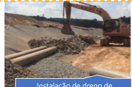
Instalação de dreno de percolado (Fonte: Cepollina, 2016)
