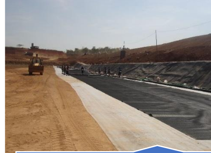
Instalação de manta PEAD sobre o GCL. (Fonte: Cepollina, 2017)
