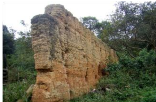
Parede de taipa de pilão
