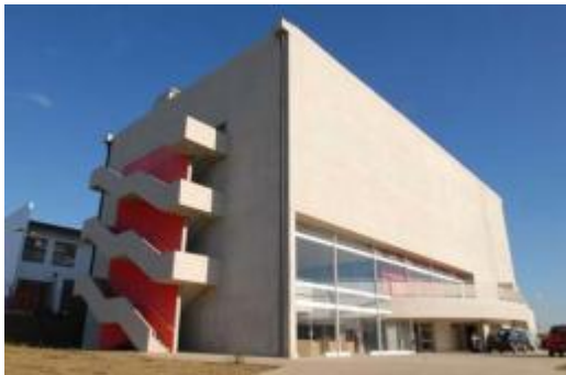
Teatro Ponte Alta
