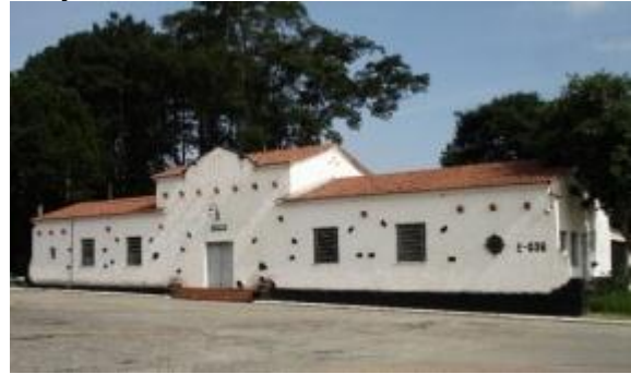
Estação Ferroviária de Cumbica – Base
