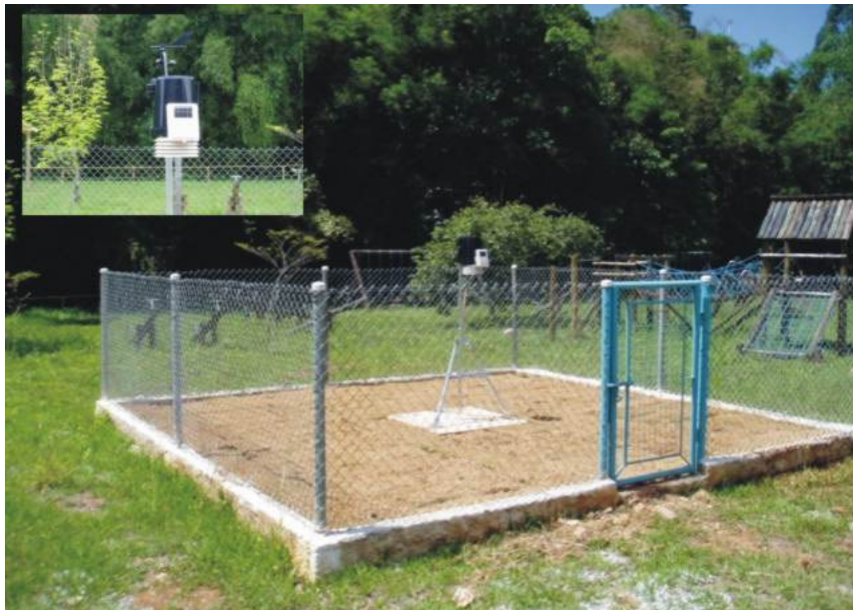
Figura 08 - Estação meteorológica Davis, modelo Vantage Pro 2 Plus , instalada em 08 de setembro de 2005, em área devidamente preparada pelo SAAE.
