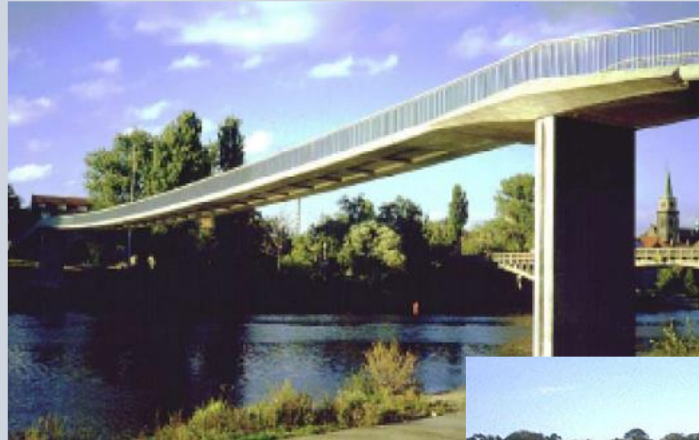
Passarela em Nyburk, República Tcheca
