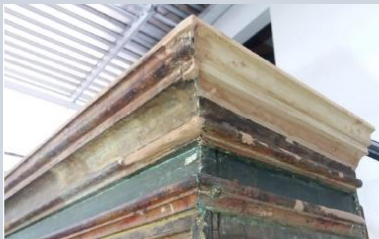
Limpeza destinada a revelar a técnica trompe l'oeil
