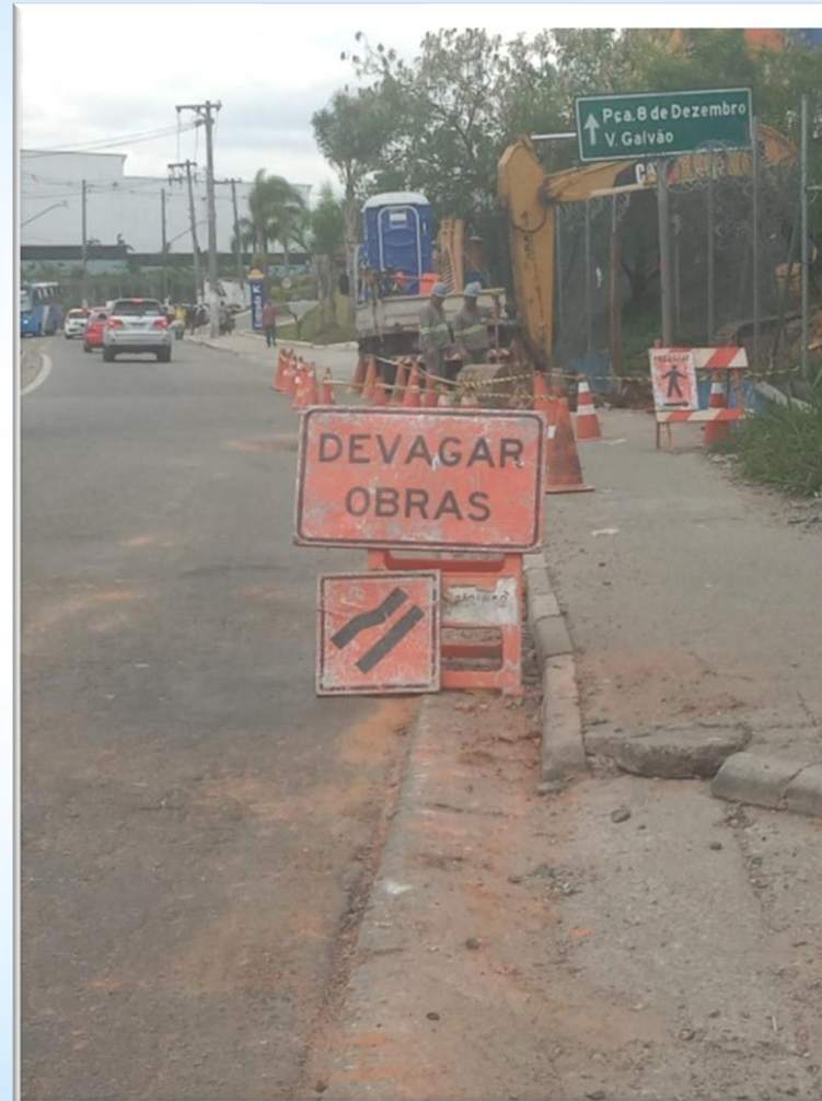
Coletor Tronco Sinalização - Av. Natália Zarif
