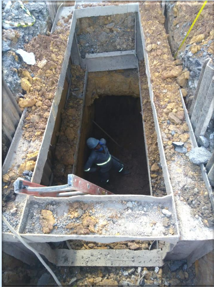
Escoramento – Av. Martins Jr. – CT09
