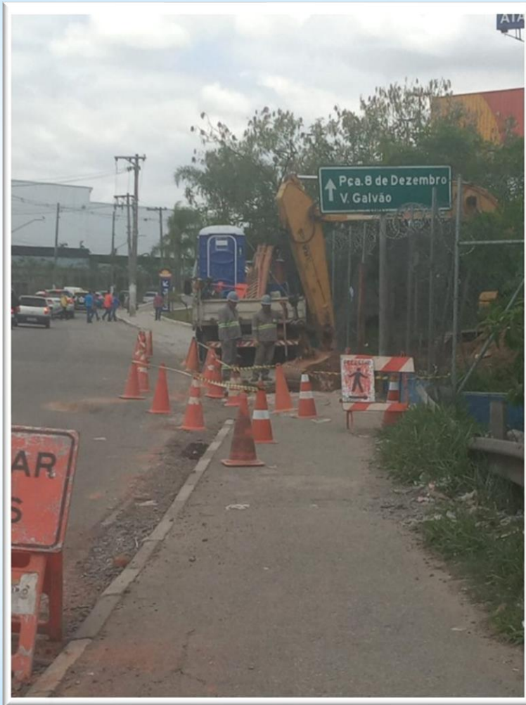
Coletor Tronco Sinalização – Av. Natália Zarif
