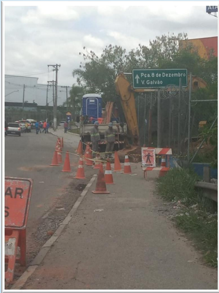
Coletor Tronco Sinalização – Av. Natália Zarif
