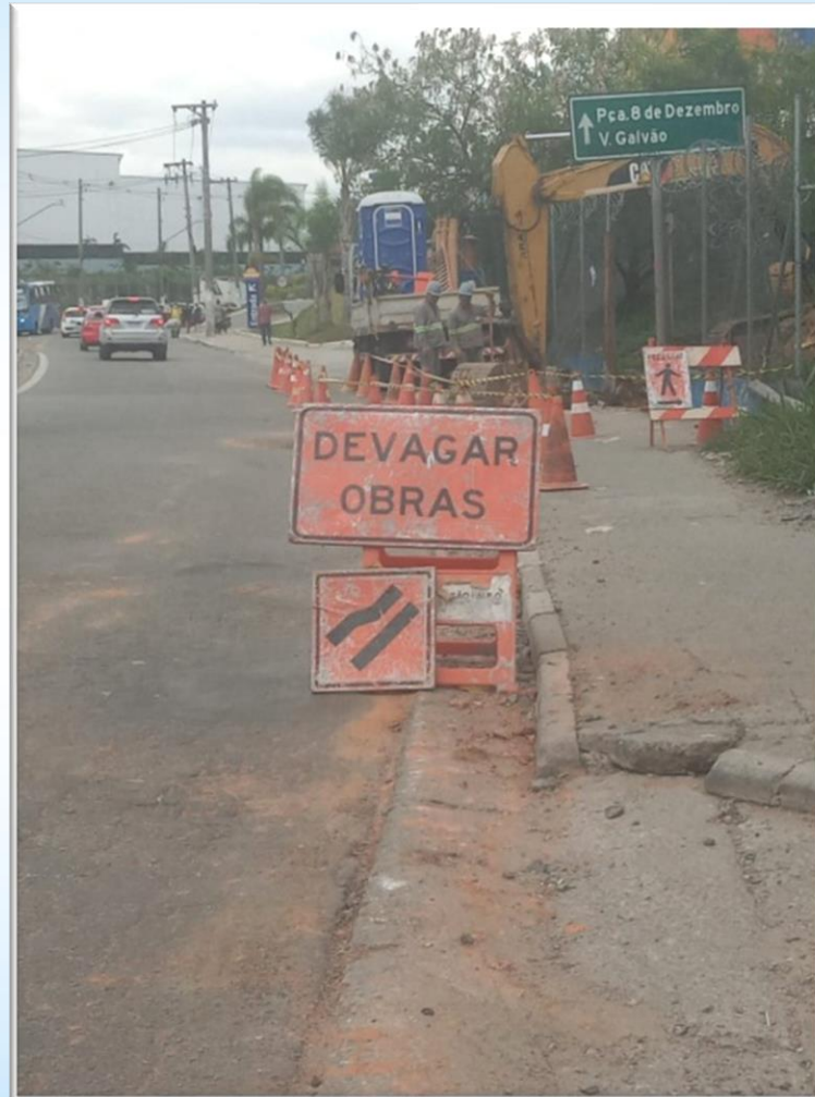
Coletor Tronco Sinalização - Av. Natália Zarif
