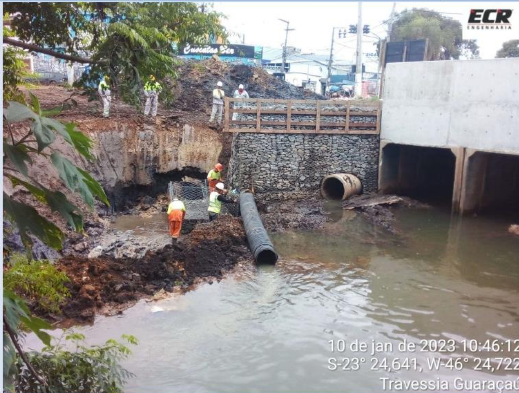
Execução do muro de gabião – Travessia Guraçau
