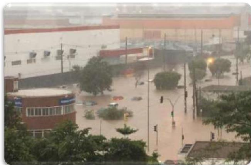
Terminal de ônibus Taboão e Av. Natália Zarif alagados Janeiro/2019 (Enchente do Rio Baquirivu)
