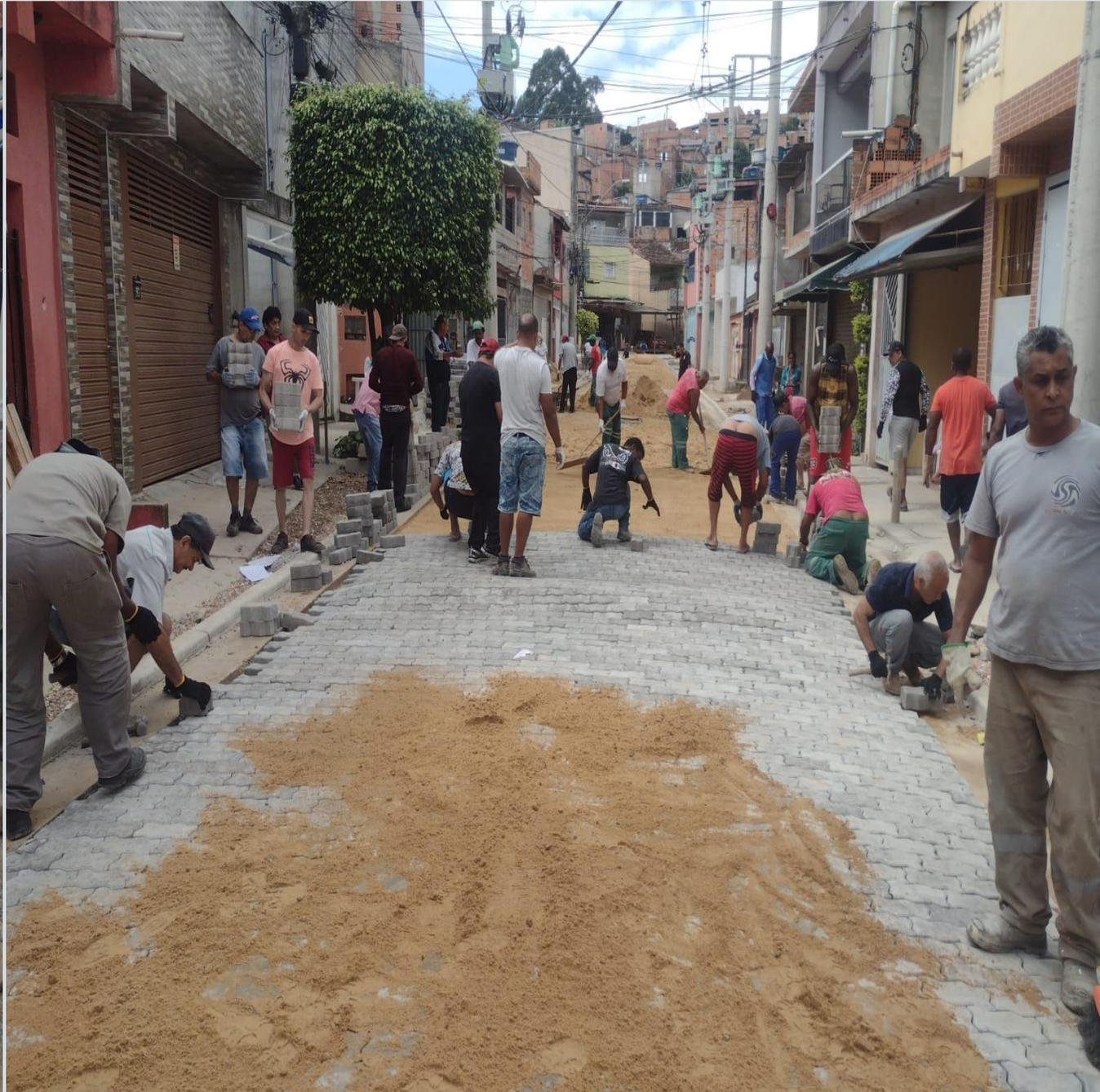
Obra de pavimentação durante a fase de assentamento de pisos
