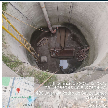
CT CABUÇU DE CIMA 1 TÚNEL NATM
