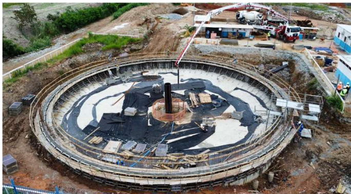
Decantador Secundário – Concretagem das paredes.
