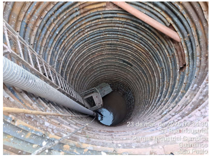
CT JARDIM CENTENÁRIO ESCAVAÇÃO DE POÇO DE SERVIÇO
