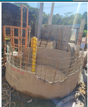
EEE FORTALEZA ESCAVAÇÃO DE POÇOS
