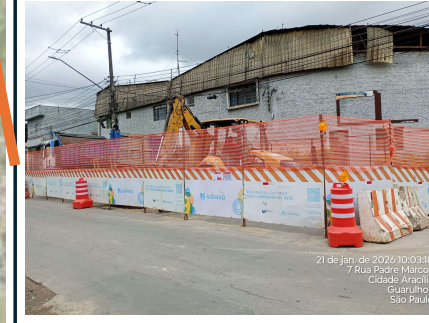
CTS RECANTO PRIMAVERA ESCAVAÇÃO DE POÇO DE SERVIÇO
