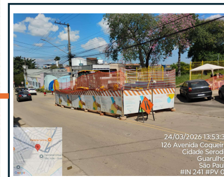
INTERLIGAÇÃO 241 ESCAVAÇÃO DE POÇO DE SERVIÇO
