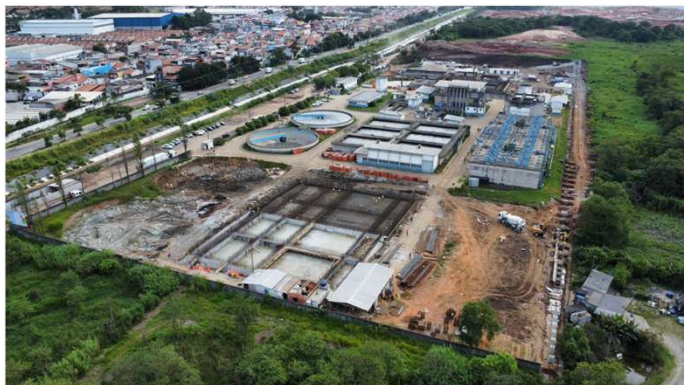
Vista geral aérea.
