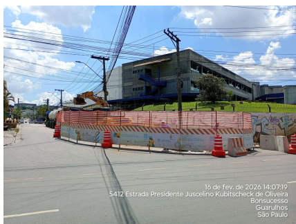
CT PARQUE DAS NAÇÕES ESCAVAÇÃO DE POÇO DE SERVIÇO
