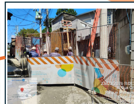
INTERLIGAÇÃO 160 VALA À CÉU ABERTO
