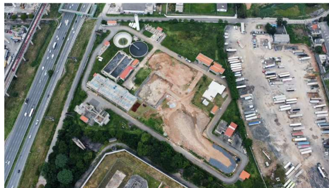
Vista geral aérea.
