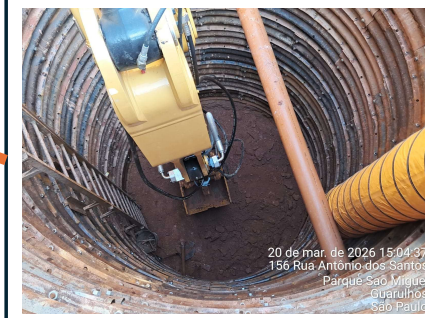
CT PIMENTAS ESCAVAÇÃO DE POÇO DE SERVIÇO
