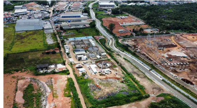
Vista geral aérea.
