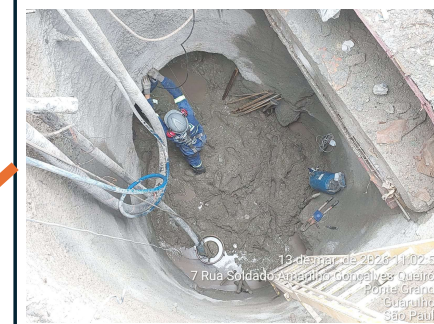
CTS 2 TÚNEL NATM
