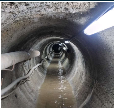
CT CABUÇU DE CIMA 1 TÚNEL NATM
