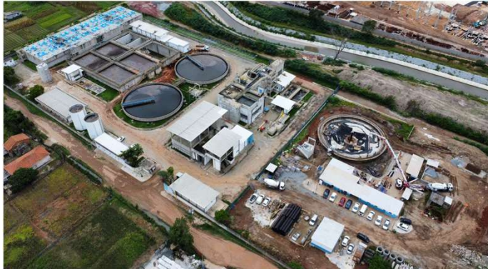
À esquerda: Em operação; À Direita: Ampliação.
