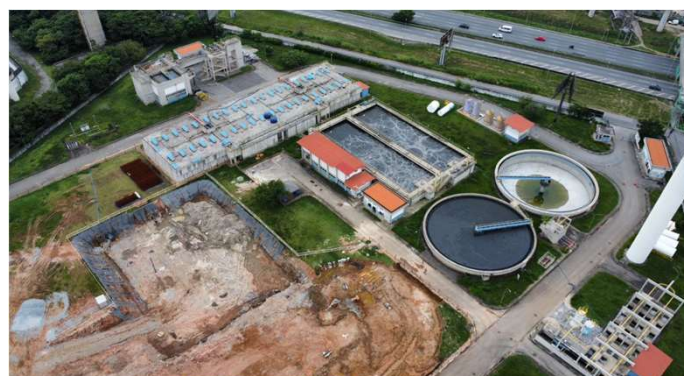
Vista Geral obras
