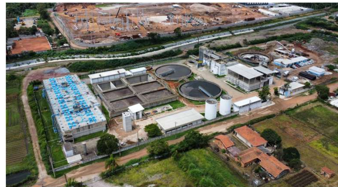
Vista geral das obras.
