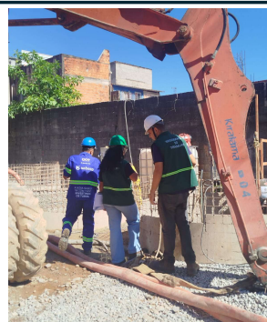
EEE FORTALEZA TÚNEL LINER
